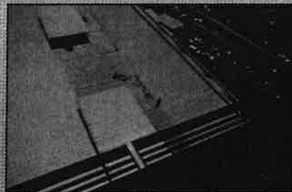
Blok Podium, Aras 5 - Kretakan Pada Permukaan Bumbung Konkrit Rata Telah Diperbaiki (Sumber: JKR – 19.03.2014)
