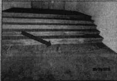
Tempat Letak Kereta – Aras 4 -Lapan Yang Tidak Sempurna Pada Permukaan Lantai (29.10.2013)
