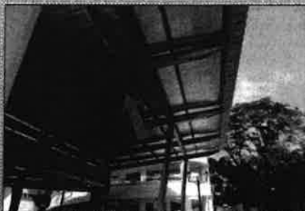
Tempat Letak Kenderaan - Roof Insulation Jenis Aluminium Foil Tidak Perlu Dipasang Di Tempat Kenderaan Berhumbung (30.10.2013)
