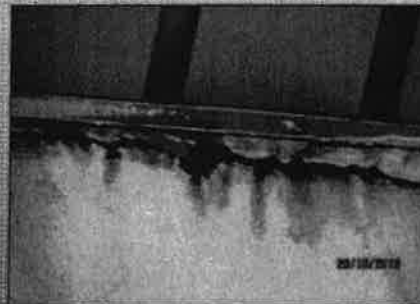
Tempat Letak Kereta – Aras 4 -Kesan Lelehan Air Pada Permukaan Dinding Menyebabkan Kulat Terbentuk (29.10.2013)
