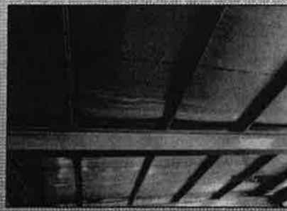
Tempat Letak Kenderaan - Roof Insulation Jenis Aluminium Foil Tidak Perlu Dipasang Di Tempat Kenderaan Berhumbung (30.10.2013)
