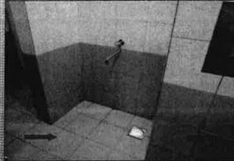
Tempat Mengambil Wuduk, Bangunan Pentadbiran - Tempat Mengambil Wuduk Tidak Mempunyai Bekendul Dan Ini Boleh Menyebabkan Air Mengalir Di Kawasan Berhampiran (28.10.2013)
