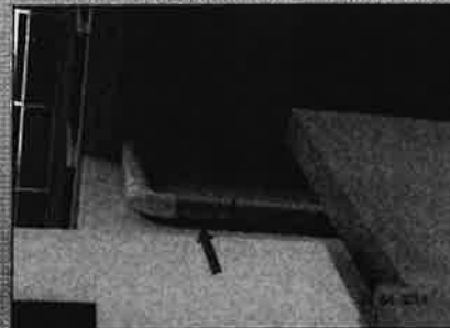
Bangunan Pentadbiran, Aras 1 - Paip Salur Keluar Telah Disambungkan Terus Ke Longkang (Sumber: JKR - 04.04.2014)
