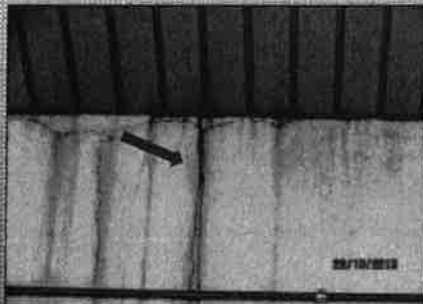
Tempat Letak Kereta – Aras 4 -Kesan Lelehan Air Pada Permukaan Dinding Menyebabkan Kulat Terbentuk (29.10.2013)
