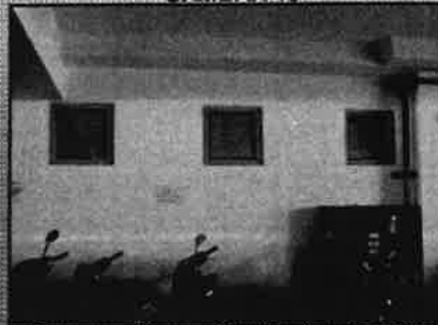
Bangunan Pentadbiran, Aras 1 (Tandas Dan Bilik Mandi Wanita) - Kedudukan Tingkap Tandas Dan Bilik Mandi Wanita Di Bahagian Luar Dimana Tingkap Ini Mudah Dibuka Dari Luar (Bahagian Tempat Letak Kenderaan) (29.10.2013 dan 13.03.14)
