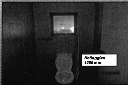
Tandas Dan Bilik Mandi Wanita, Aras 3, Bangunan Pentadbiran - Ketinggian Pemasangan Tingkap Yang Tidak Sesuai Akan Menjejaskan Keselesaan Kepada Pengguna Wanita Dimana Ketinggian Antara Lantai Dengan Tingkap Adalah 1200 mm. (19.03.2014)
