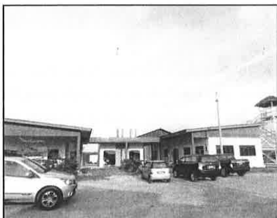
Lokasi: Selinsing, Perak Tarikh: 13 Oktober 2014
