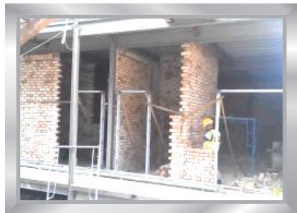
Pembinaan dinding bata dan bingkai pintu di bilik booster pump
