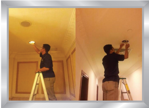
Kerja-kerja membaiki lampu jenis downlight di Bilik Diraja sedang dilaksanakan
