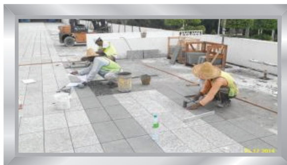
Pemasangan kemasan granite di Padang Kawad
