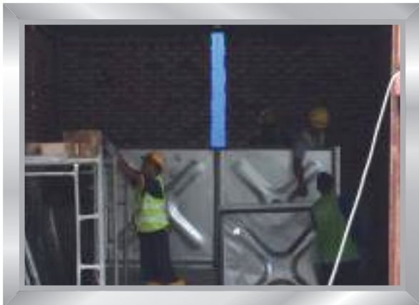
Pemasangan tangki gelung hos
