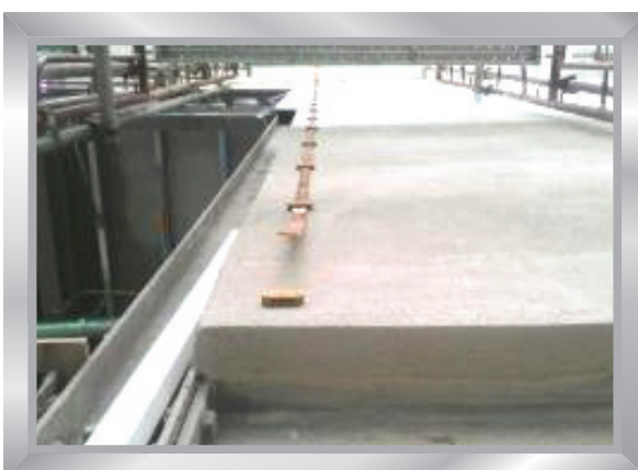
Pemasangan copper tape untuk lightning system
