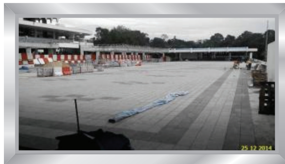
Pemasangan kemasan granite di Padang Kawad
