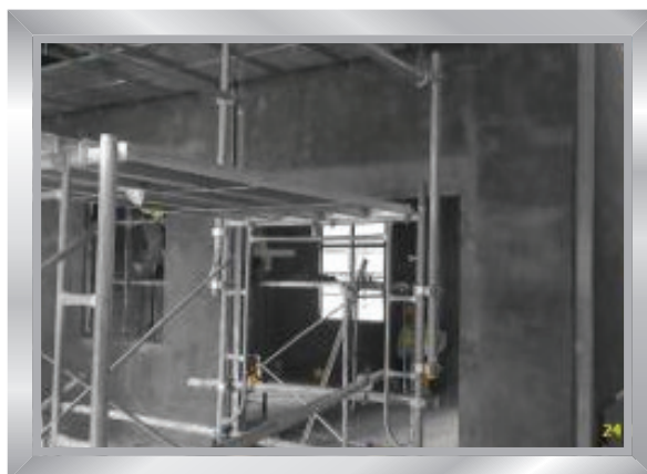
Kerja Melepa Dinding Bata di Pantri 2 aras bawah telah siap
