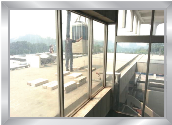
Outdoor aircond unit dalam proses pemasangan
