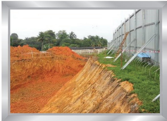
Kerja pemotongan tanah untuk pagar
