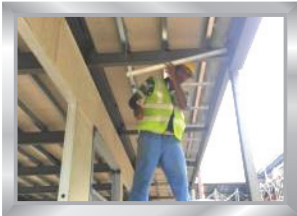
Pemasangan back-box untuk ICT
