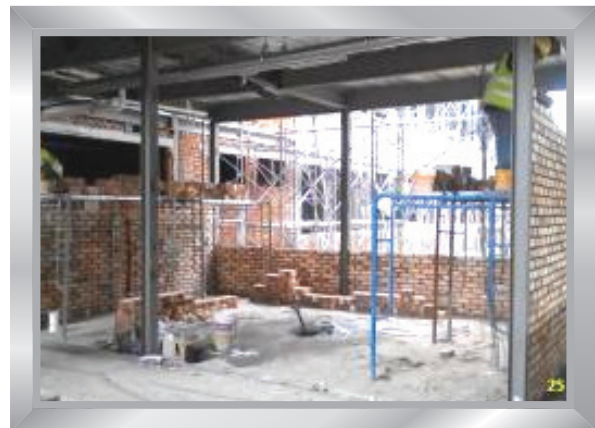
Pembinaan dinding bata untuk Pantri Aras Bawah
