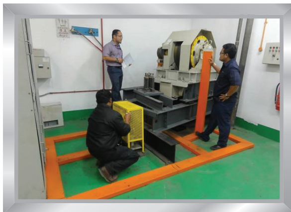
Pemeriksaan di Bilik Motor Lif di Blok Menara
