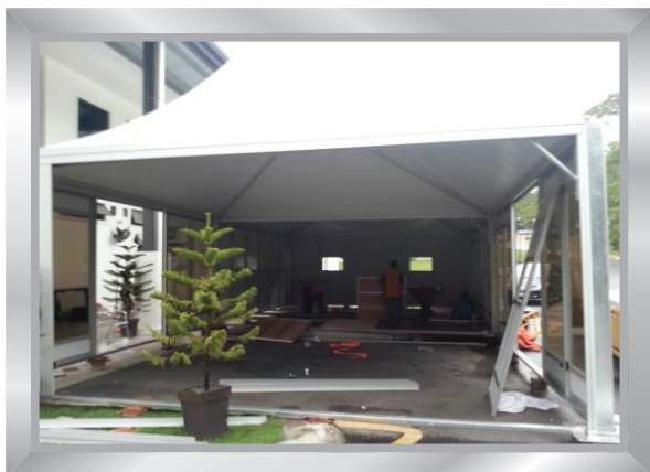
Kerja-kerja pemasangan lantai sedang dilaksanakan
