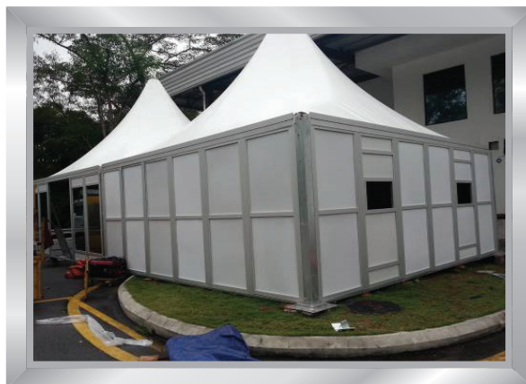
Kerja-kerja pemasangan dinding sedang dilaksanakan
