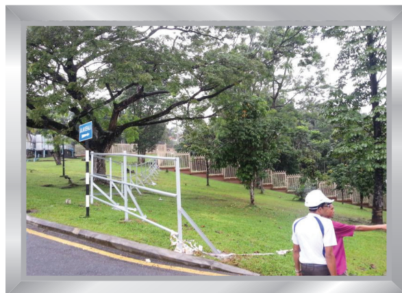
Kerja pemasangan hoarding
