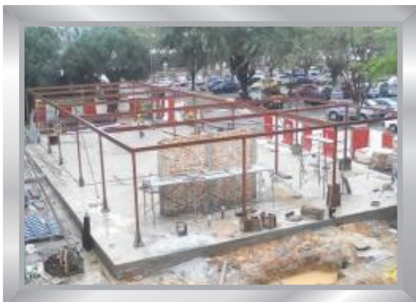
Pemasangan struktur keluli dan pembinaan dinding bata
