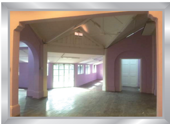
Keadaan dalam bangunan selepas naiktaraf
