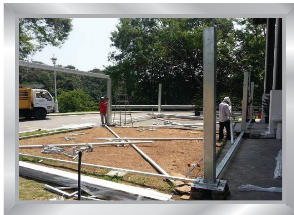
Rangka struktur khemah sedang dibina
