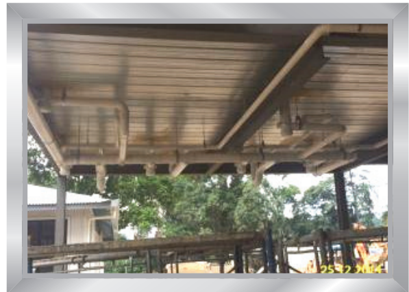
Pemasangan paip sanitari
