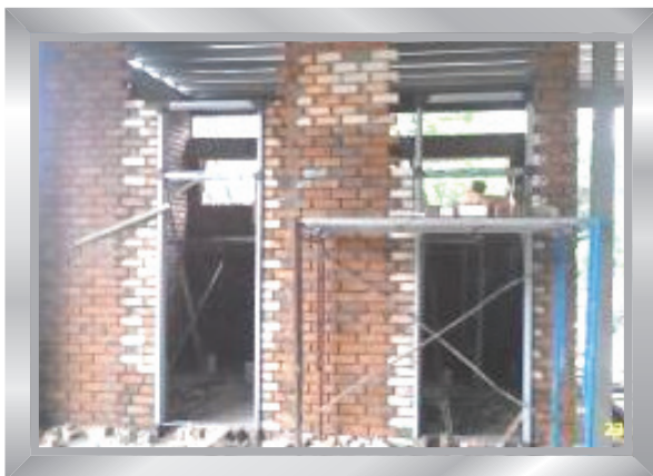
Pembinaan dinding bata dan bingkai pintu di tandas no. 4
