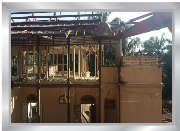
Kerja soft demolition telah selesai
