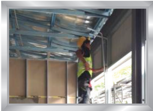
Pemasangan sesalur untuk ICT
