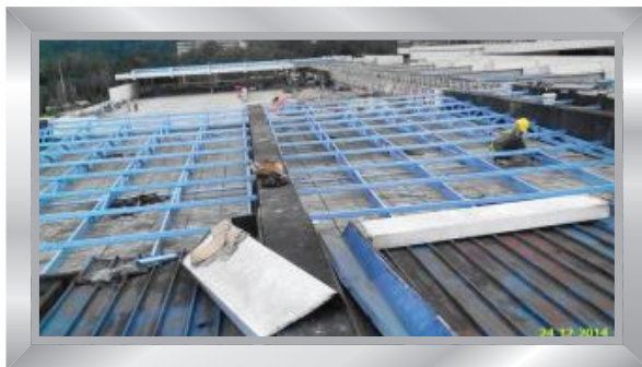
Pemasangan kekuda bumbung astaka
