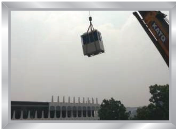
Outdoor aircond unit dalam proses pemasangan
