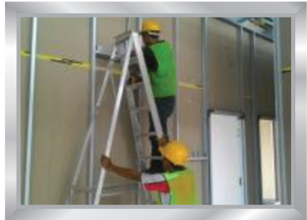
Pemasangan ducting untuk Sistem Pengudaraan
