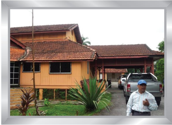
Keadaan asal bangunan
