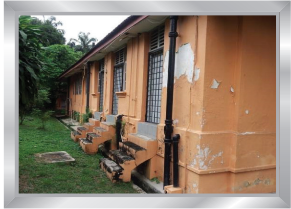
Keadaan asal bangunan
