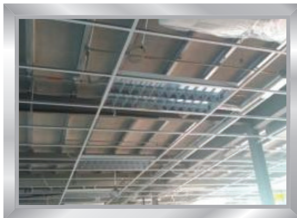
Pemasangan light fittings di Bilik Taklimat
