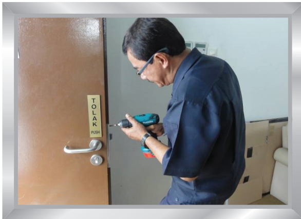
Kerja pemasangan dan pembaikan tombol pintu
