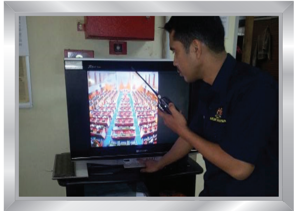
Kerja-kerja menyelenggara Sistem SMATV
