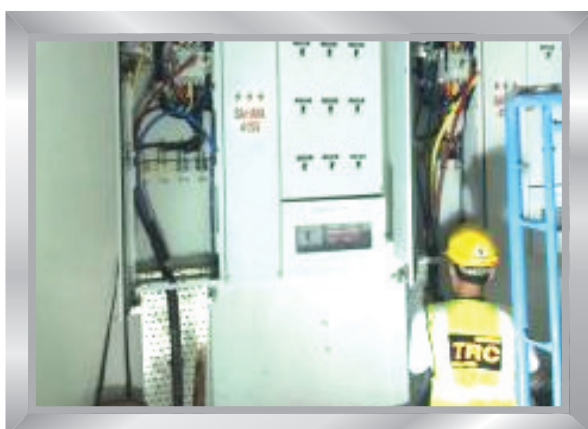
Persediaan untuk sub-switch board termination
