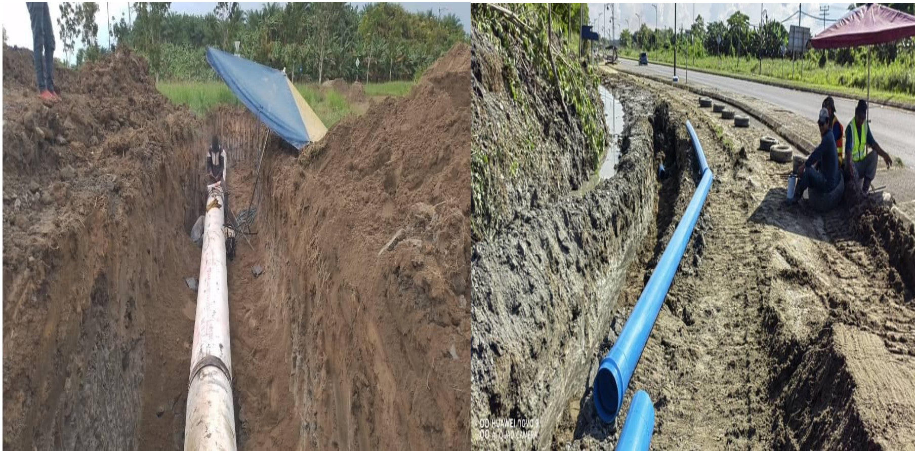
Kerja-kerja pemasangan paip jenis PVC-O
