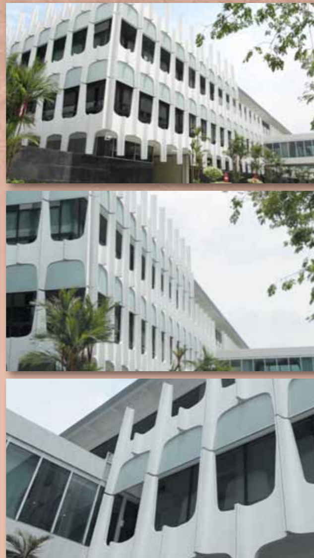
Panel-panel fasad di Blok Utama yang telah siap dibaiki
