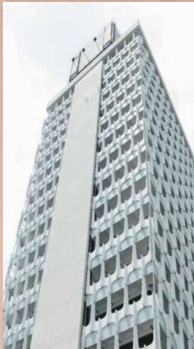
Permukaan terrazzo panel fasad di Blok Menara yang telah siap dibaiki.
