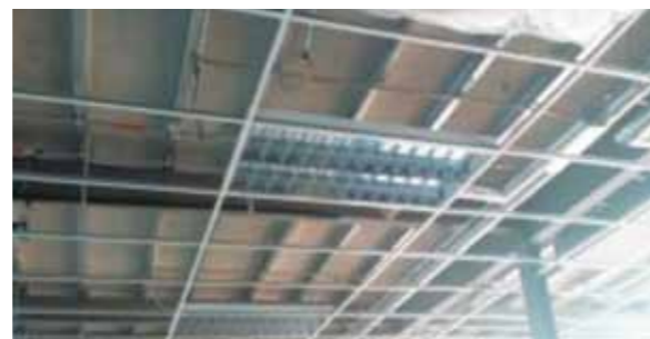
Pemasangan light fittings di Bilik Taklimat
