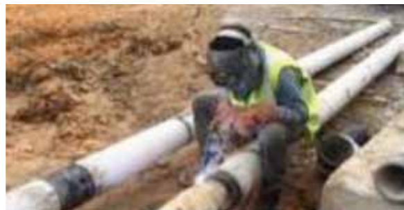
Kerja luaran: Kerja kimpalan untuk paip air luaran
