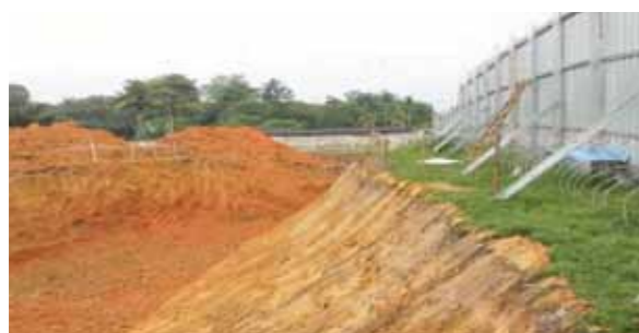
Kerja pemotongan tanah untuk pagar
