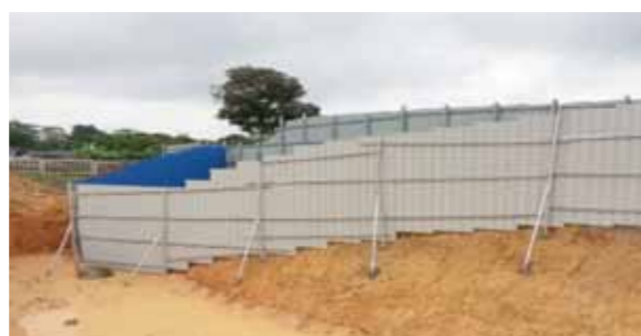
Kerja pemasangan pagar keselamatan selesai di Kawasan Sempadan Fasa 2B
