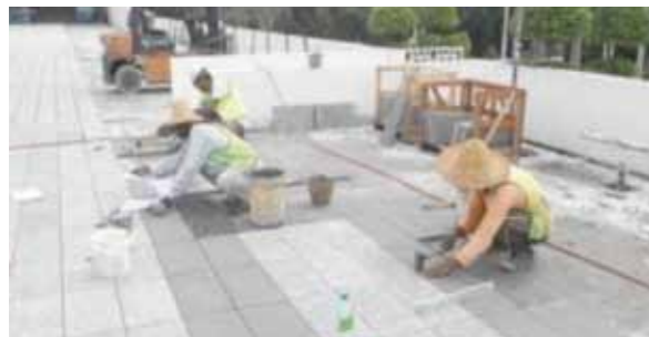
Pemasang kemasan granite di Padang Kawad
