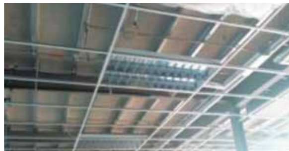
Pemasangan light fittings di Bilik Taklimat
