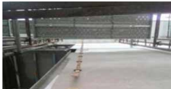
Pemasangan copper tape untuk lightning system
