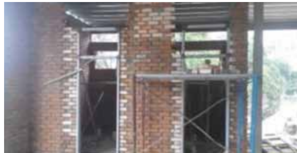
Pembinaan dinding bata dan bingkai pintu di Tandas no.4.
