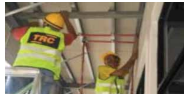
Menarik kabel untuk sistem pencegah kebakaran
