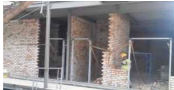
Pembinaan dinding bata dan bingkai pintu di Bilik Booster Pump
