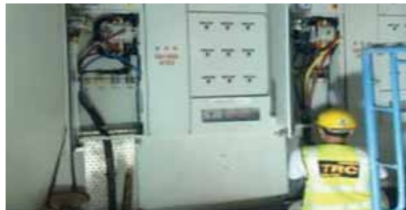
Persediaan untuk sub-switch board termination
