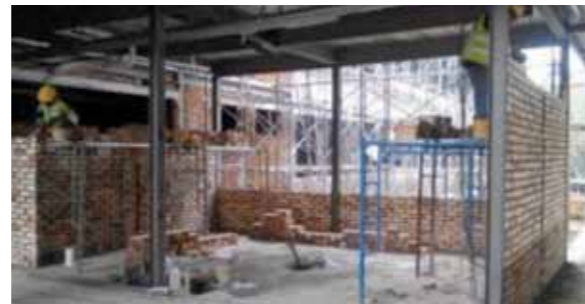
Pembinaan dinding bata untuk pantri aras bawah
