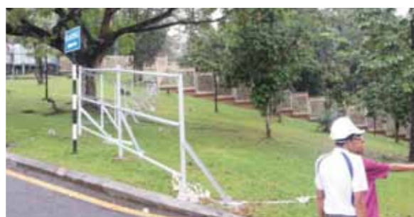
Kerja pemasangan hoarding
