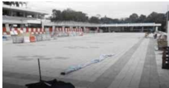
Pemasang kemasan granite di Padang Kawad
