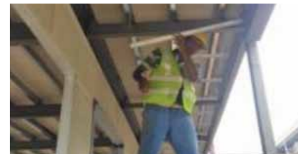
Pemasangan back-box untuk ICT
