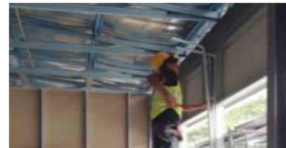
Pemasangan sesalur untuk ICT
