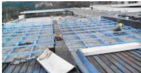
Pemasangan kekuda bumbung astaka
