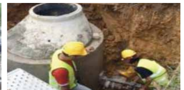
Pembinaan manhole pembentungan
