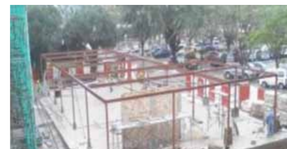
Pemasangan struktur keluli dan pembinaan dinding bata
