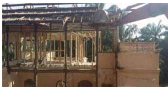
Kerja soft demolition telah selesai
