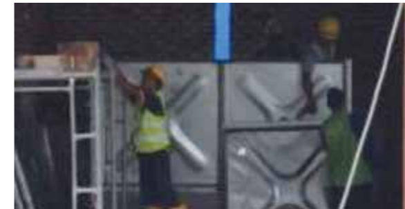
Pemasangan tangki gelung hos
