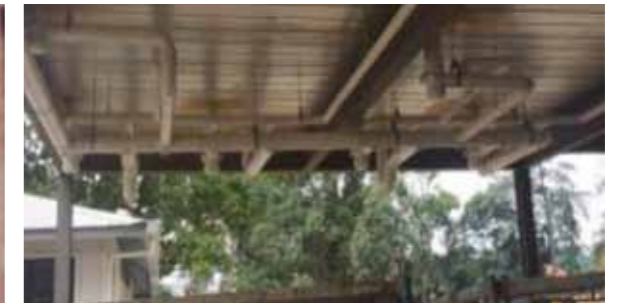
Pemasangan paip sanitari
