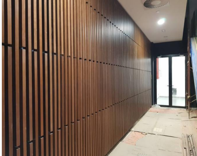
Pemasangan wall panel
