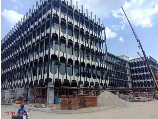
Pemasangan Fasad Zon C
