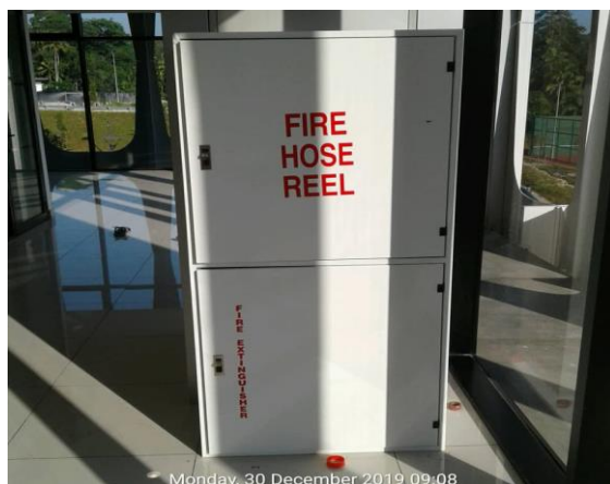
Kerja Pemasangan Kabinet Hose Reel
