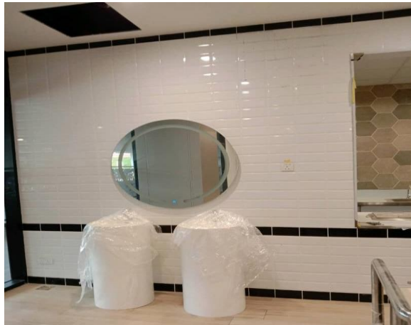
Aras Tanah – Kafeteria
