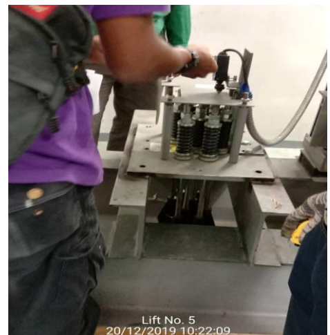
Kerja Pemeriksaan Lift
