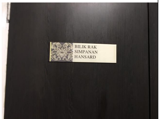
Aras 1 – Kerja Pemasangan Signage
