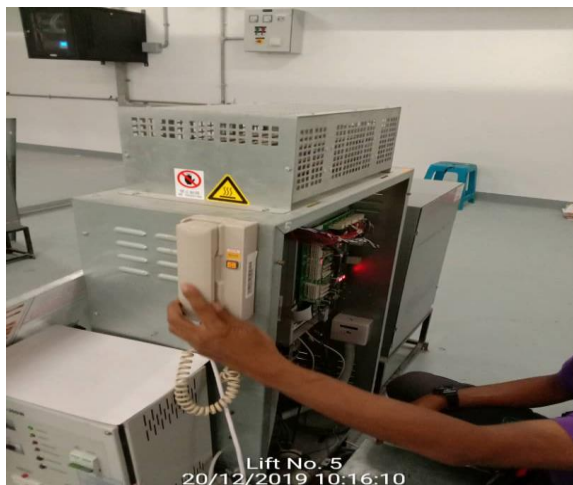
Kerja Pemeriksaan Lift
